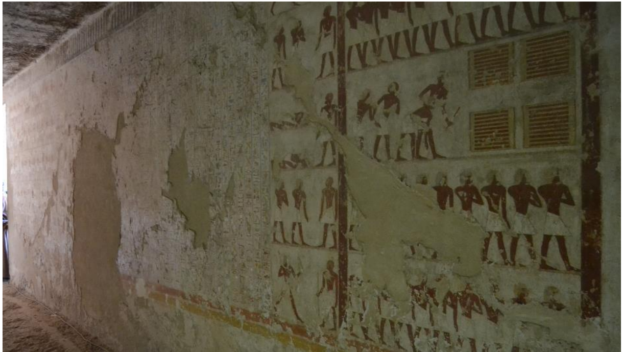
Fig. 20. Pared este del área sur del vestíbulo. © Marina Esteve.
