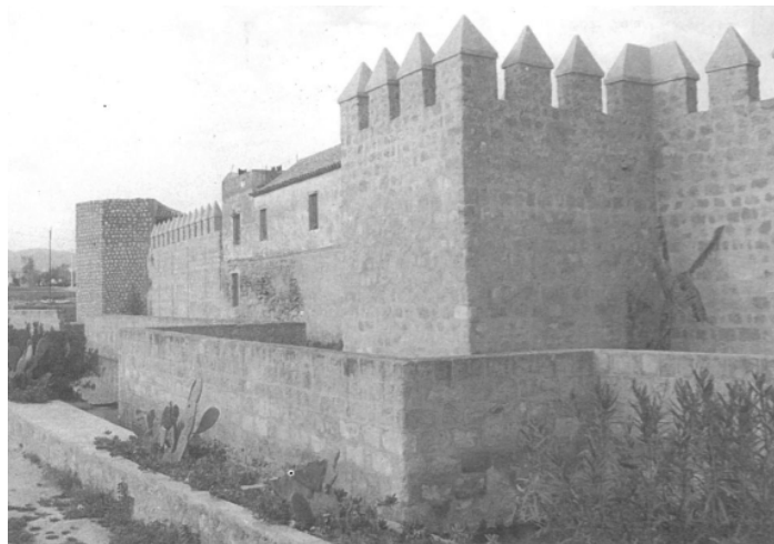
Figura 26. Córdoba. Estado del amurallado de la Puerta de Sevilla antes de su restauración (Márquez, 2007: anexo 4). Figura 27. Córdoba. Estado del amurallado de la Puerta de Sevilla después de su restauración. Obsérvese la recomposición casi completa del almenado, foso y torreones. Años 50 (Márquez, 2007: anexo 5).
