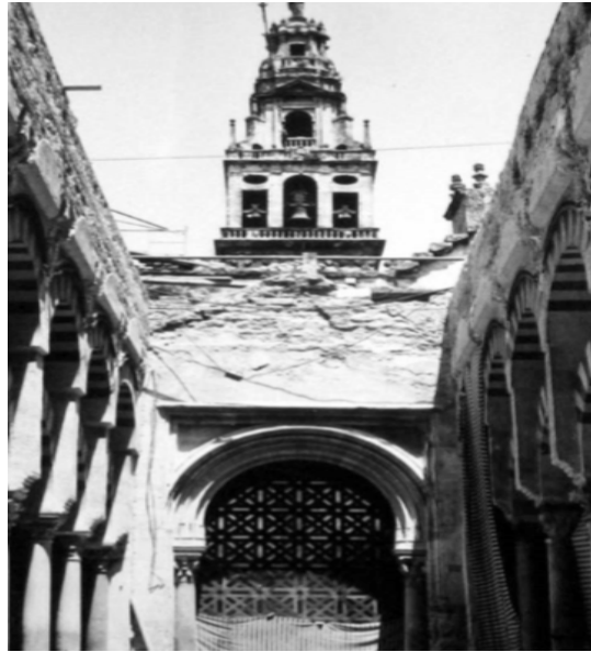
Figura 14. Córdoba. Mezquita-Catedral. Proceso de restitución de las cubiertas de la mezquita fundacional en 1975 (Herrero, 2015a: 214).
