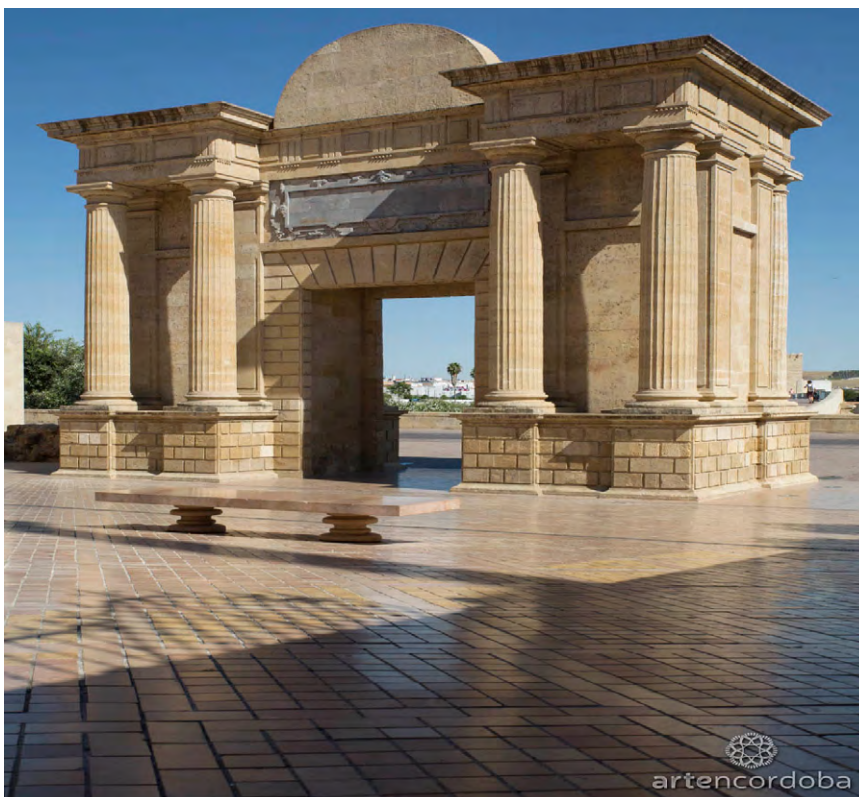
Figura 31. Córdoba. Puerta del Puente. Estado actual de la fachada norte realizada en 1928.
