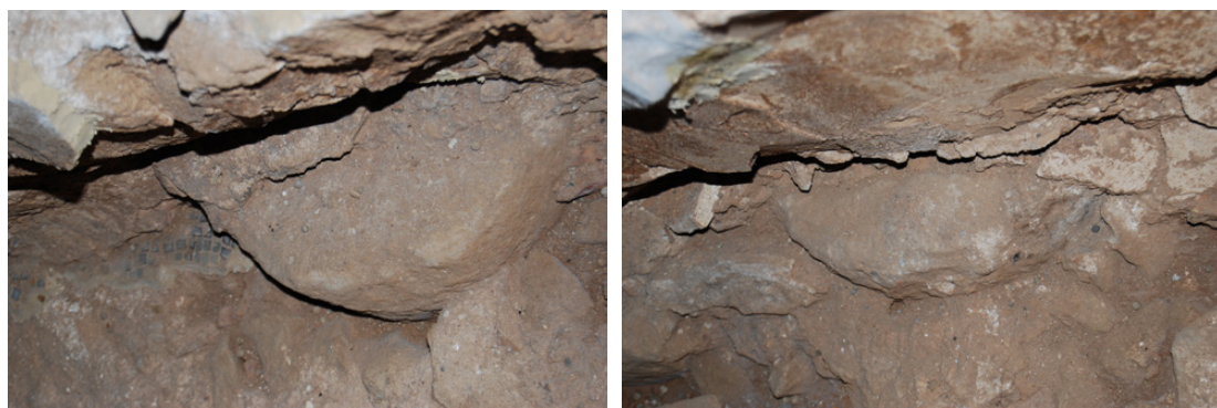
Fig. 5. Pilares de piedra que se vislumbran bajo el tabique de tapial (que separa la habitación 1 de la 2) y es el resultado de una reforma posterior. Fotografías: A. Vilardell.
