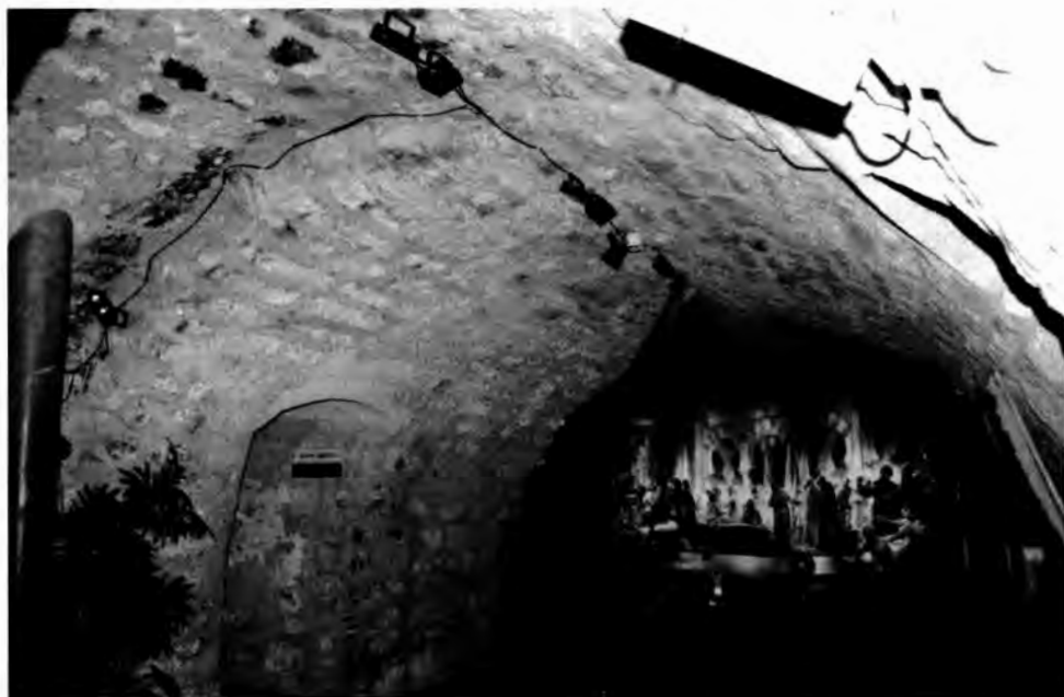
Lámina 7: Intradós de la bóveda conservada en el segundo piso interior de la torre.
