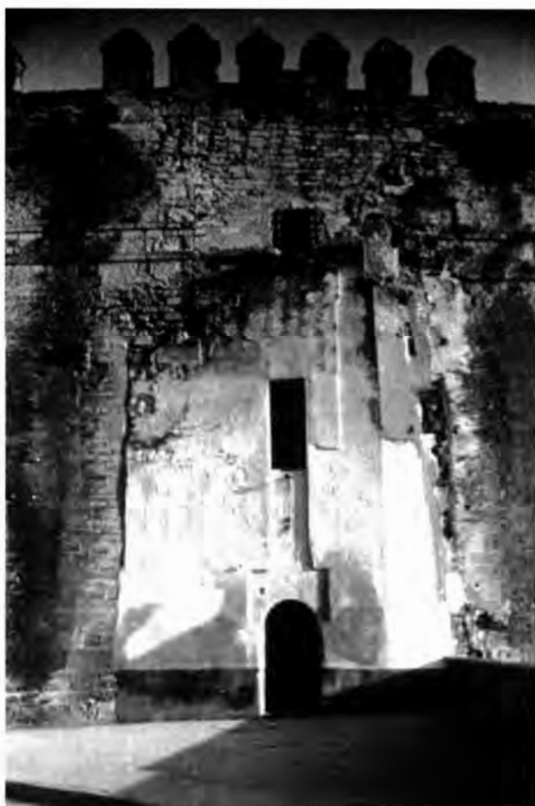
Lámina 5: Estado previo de la Calahorra antes de su rehabilitación durante la década de 1950-1960 (Archivo Fotográfico de D. Antonio Cruz Conde).
