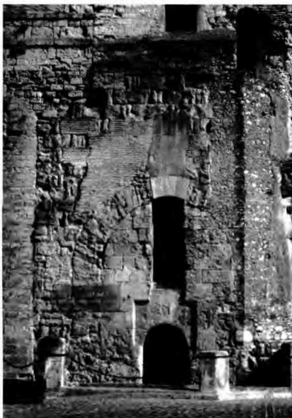
Lámina 3: Vista frontal de los restos pertenecientes a la torre y el arco islámicos.
