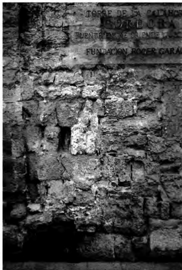
Lámina 6: Detalle de la jamba oriental original, parcialmente conservada y reparada con reformas cristianas, sobre la que apoya la imposta biselada de mármol blanco (ver fig. 3).
