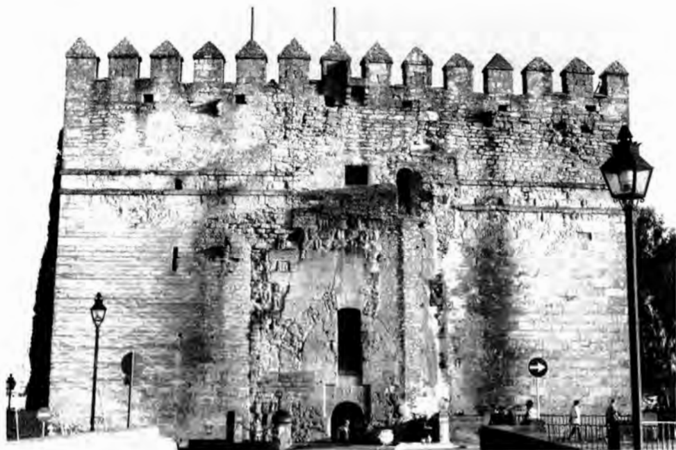
Lámina 1: Vista frontal de la fachada principal, lado norte, de la torre de la Calahorra.
