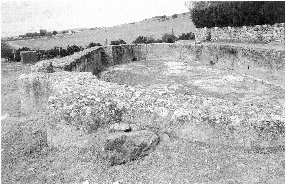
Fig. 5. La gran cisterna de Las Pitillas, con contrafuertes semicilíndricos en cada uno de los dos ábsides de remate de sus extremos.
