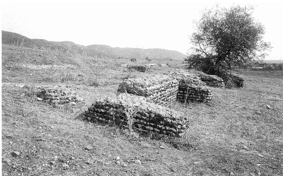
Fig. 4. Cisterna de Córdoba La Vieja con contrafuertes en el flanco de mayor pendiente
