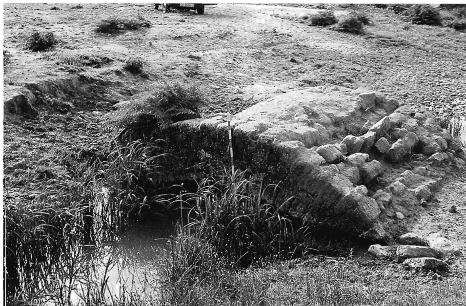
Fig. 12.- Puente sobre el arroyo de Fontalba.
