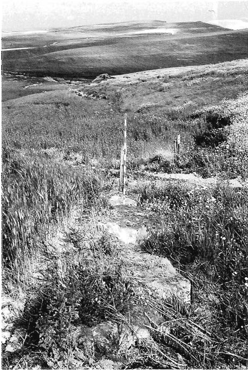
Fig. 7.- Contrafuertes laterales de la vía (sector 3.º).
