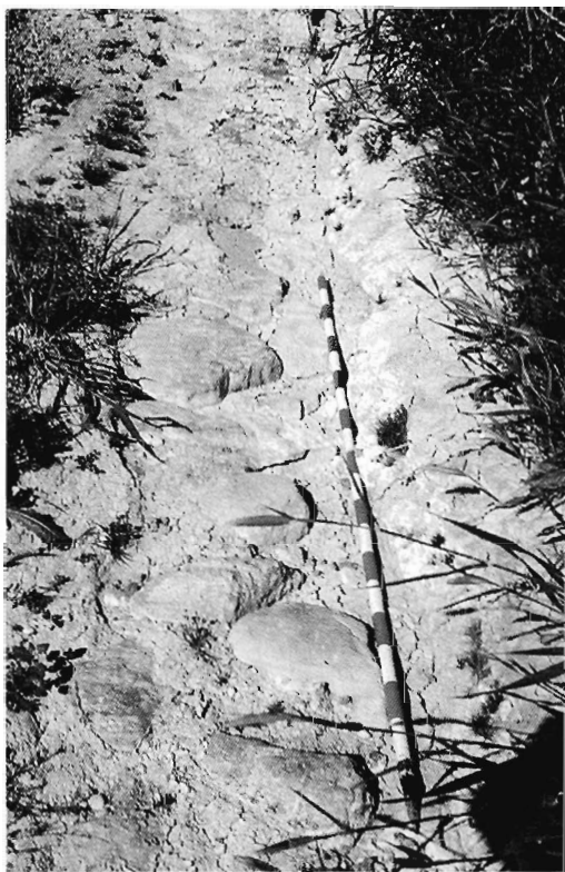
Fig. 5. Detalle del pavimento de la vía (sector 1.º).
