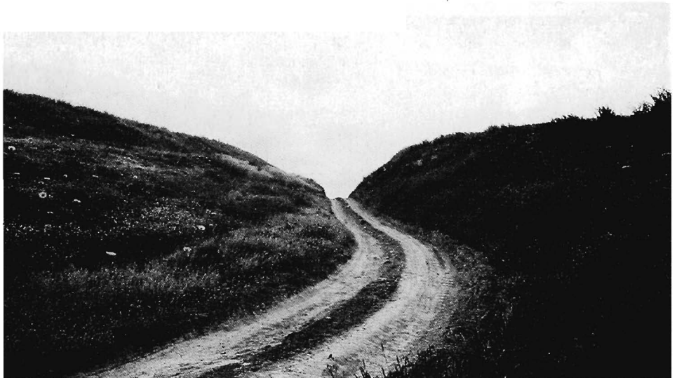
Fig. 8.- Encajonamiento del camino con el fin de aminorar la pendiente existente (sector 3.º)
