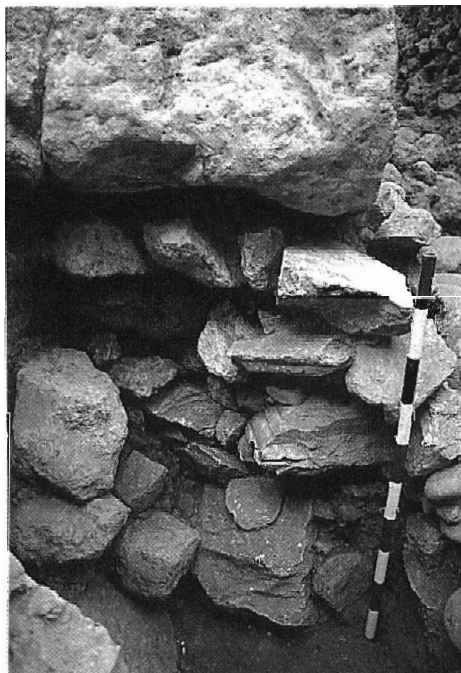
Lám. 10.- Corte 3. Detalle de la cimentación del muro U.E. 113 con elementos reutilizados del recinto religioso.
