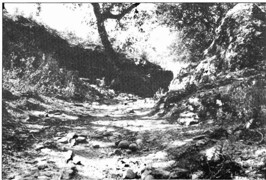
Lám. 2. Vía Corduba-Emerita a su paso por la loma de Los Escalones. La vía discurre unos metros encajonada en la roca.
