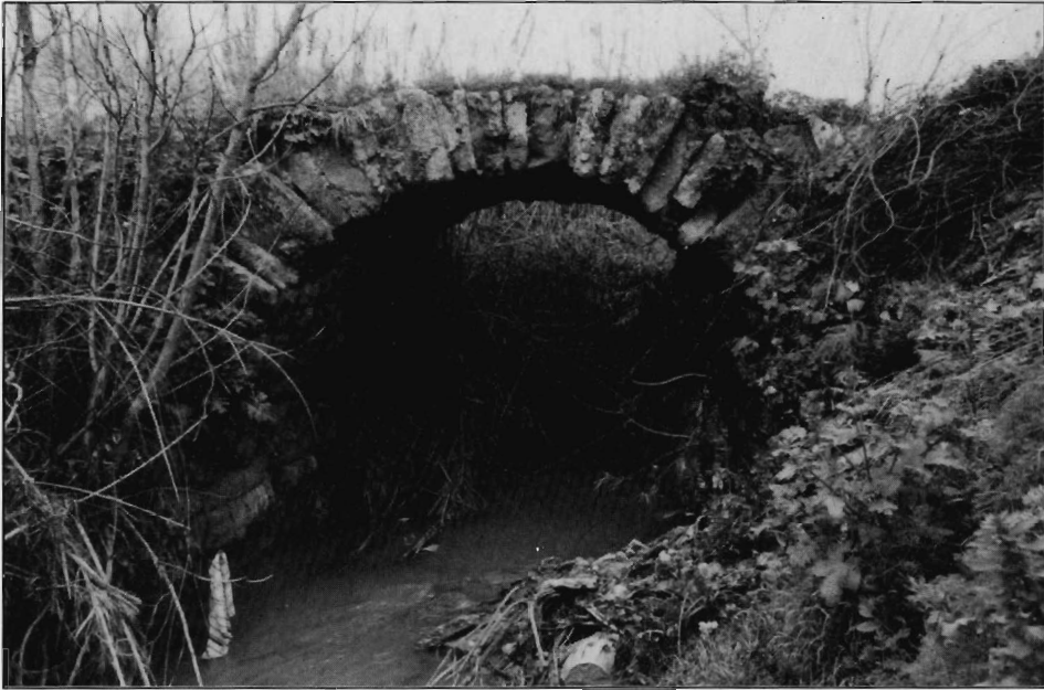
Lám. 1. (Puente n.2) Vista del arco aguas abajo.
