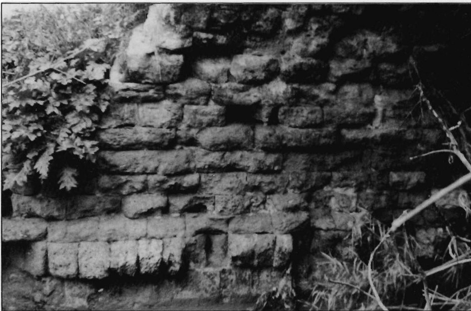
Lám. 2. (Puente n.2) Detalle de la pila Oeste; obsérvese cómo el arco apoya directamente sobre la última hilada de tizones. Ligeramente retranqueada.
