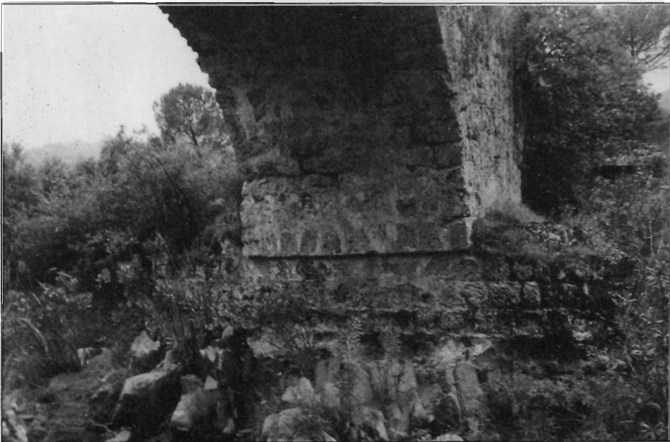
Lám. 9. (Puente n.22) Detalle de una de las pilas; obsérvese el arco retranqueado y el tajamar y espolón adosado a la pila.
