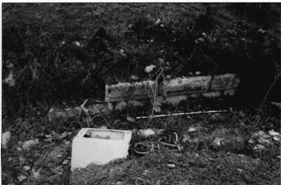
Lám. 5. (Puente n.19) Vista del puente aguas abajo.
