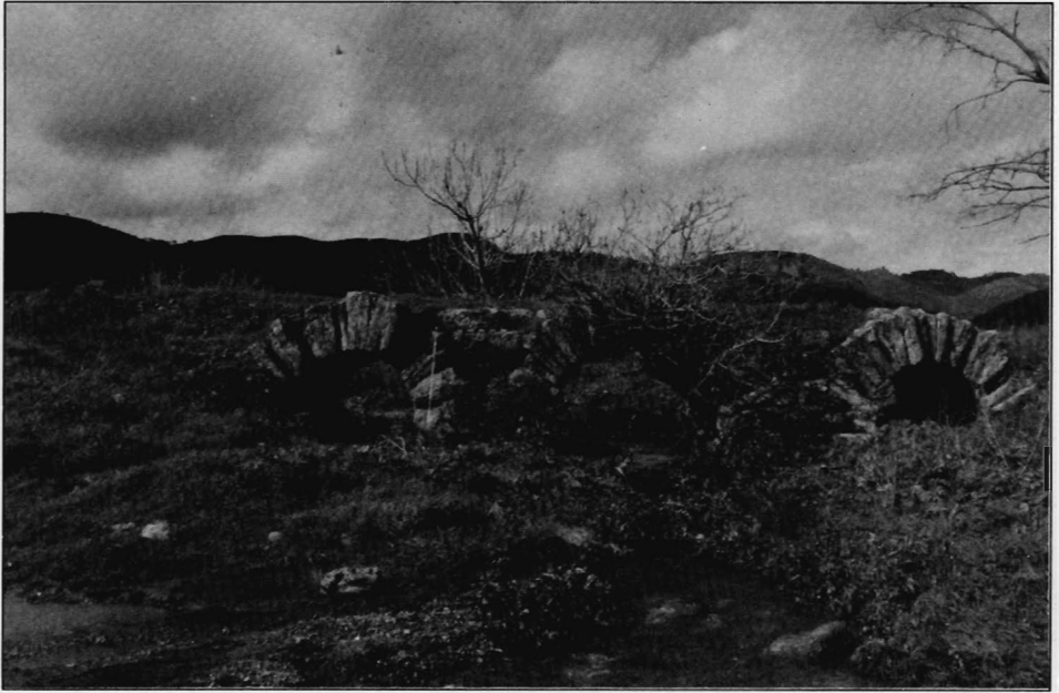
Lám. 3. (Puente n.6) Panorámica del puente aguas abajo.
