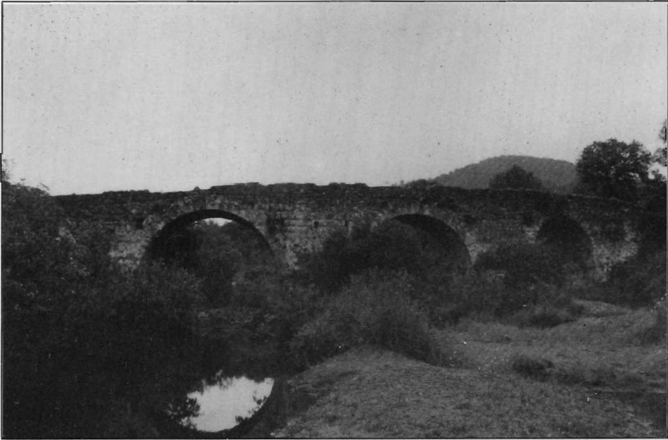
Lám. 8. (Puente n.22) Vista del puente aguas abajo.
