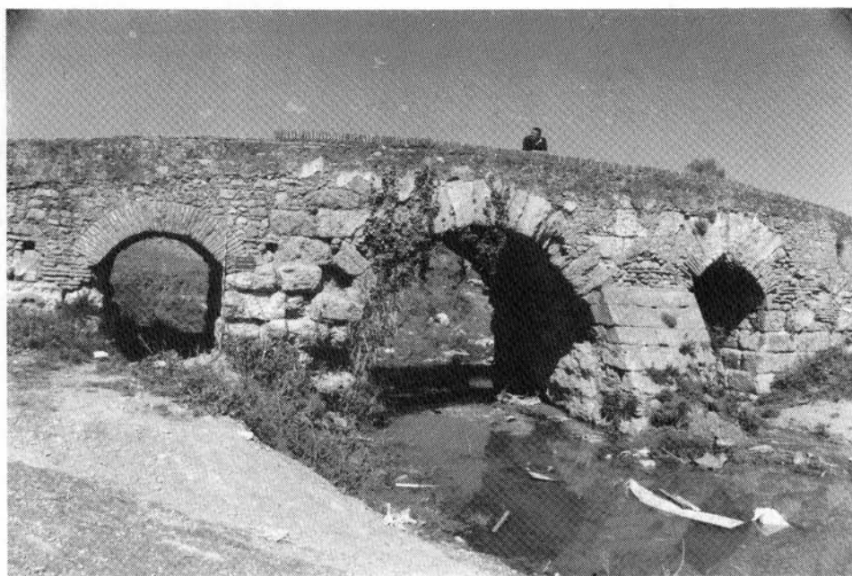
Lámina 4. a: Idem, detalle de los almohadillados y engatillado de las dovelas. b: Puente de Los Pedroches, vista general.
