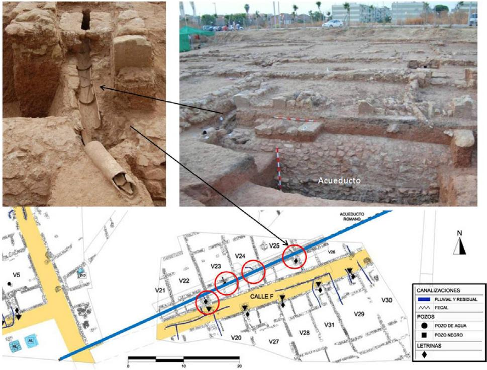
**Fig. 4.** Viviendas del arrabal del Cortijo del Cura construidas sobre el acueducto de Valdepuentes (a partir de la planimetría original cedida por R. Clapés). Imágenes de detalle de la conducción romana y de su rotura por medio de dos canalillos secundarios (CLAPÉS, 2011).
