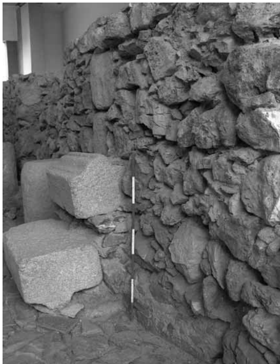
FIG. 12.- Piedra calcárea en el mampuesto y sillares para la trabazón de los cimientos (y muros).
