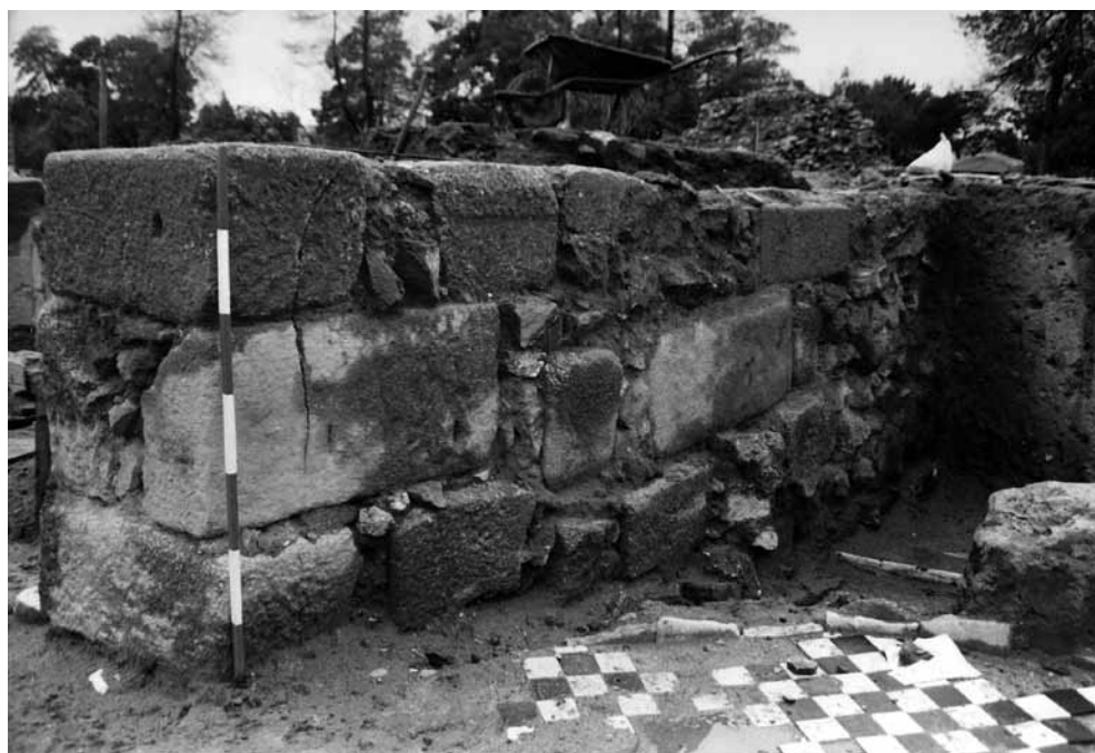
FIG. 11.- Cimentación de la fachada del edificio "B" reforzada con sillares.
