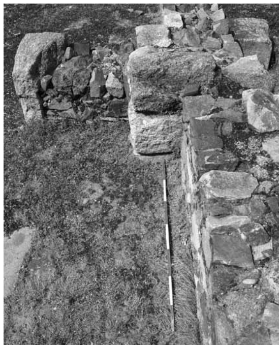
FIG. 8.- Detalle de la fábrica y de una de las esquinas con arista sobresaliente, construida con sillarejos.
