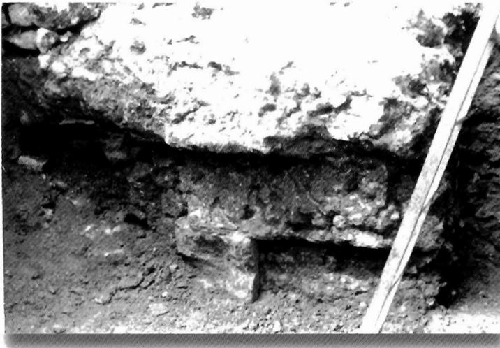
LÁMINA VI: Escalonamiento invertido en la fábrica de 'caementicium' documentado en el B-4, en el que se hallaron restos de un sillar incrustados en la misma.
