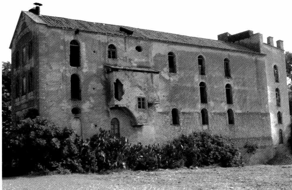
LÁM. III: Vista general del Molino de Carbonell en su estado actual.
