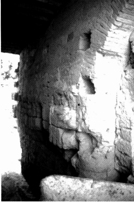
LÁM. VII: Zona de unión de los dos edificios del Molino de Lope García. Lateral Norte. En la parte inferior del paramento puede observarse una hilada continua de tizonas, obra probablemente amirí. Sobre ésta aparece otro tipo de aparejo de diferente fecha.
