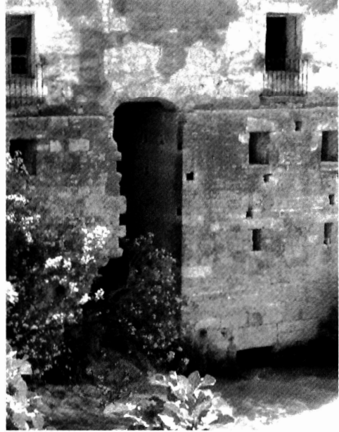
LÁM. VIII: Vista desde el exterior de la zona de unión de los dos edificios del Molino de Lope García. Obsérvese en la parte izquierda de la imagen el perfil dentado como consecuencia de un desmonte producido en época bajomedieval cristiana.
