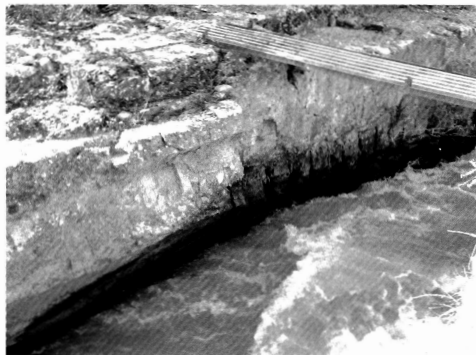
LÁM. X: Restos del estribo de unión entre el molino de Lope Garcíá y su parada. Puede apreciarse una línea continua de tizones posiblemente de época califal.
