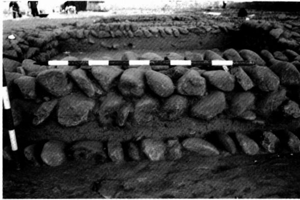
LÁM. IV: Reconstrucciones documentadas en el arrabal de Secunda
