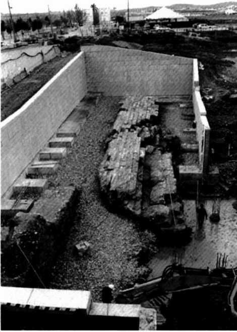
LÁM. I: Excavación integral del perímetro del malecón
