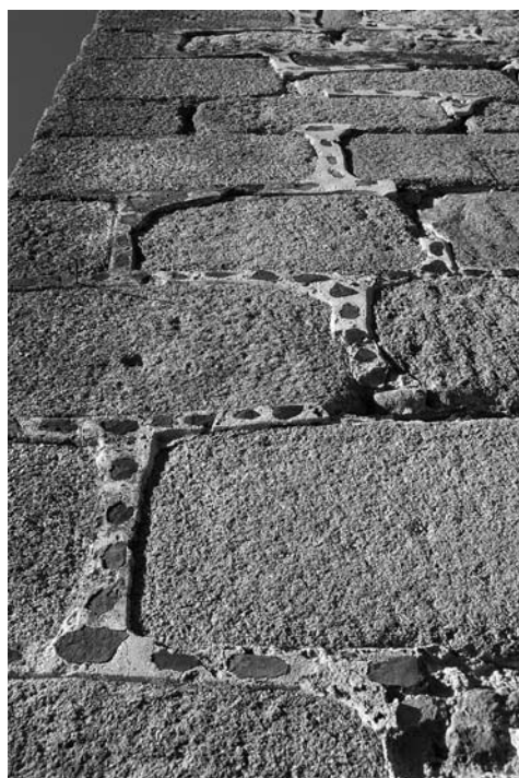
LÁMINA 11. Detalle de las fábricas del castillo de Trujillo (Cáceres).
