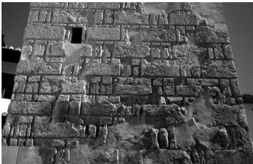
LÁMINA 6. Detalle de las fábricas de sillería del alminar zirí de San José de Granada.
