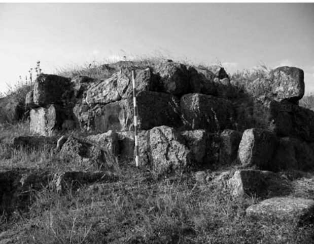
LÁMINA 5. Detalle de las fábricas empleadas por las autoridades omeyas en la reconstrucción del Castellón de Bobastro.
