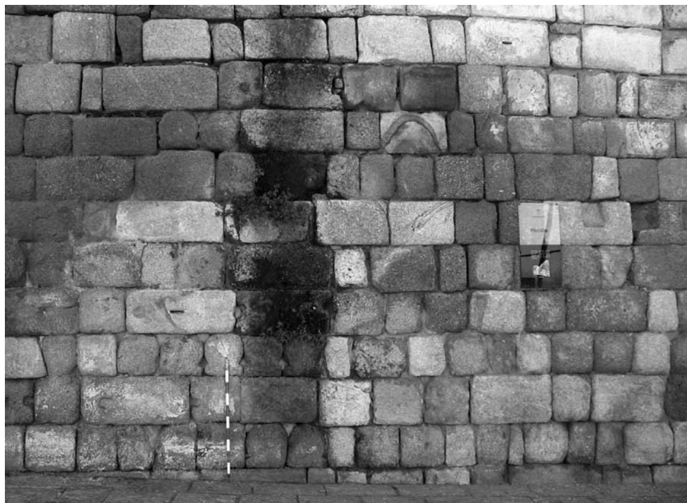
LÁMINA 1. Detalle de las murallas de Coria (Cáceres), donde destaca la construcción con material de acarreo de origen clásico.
