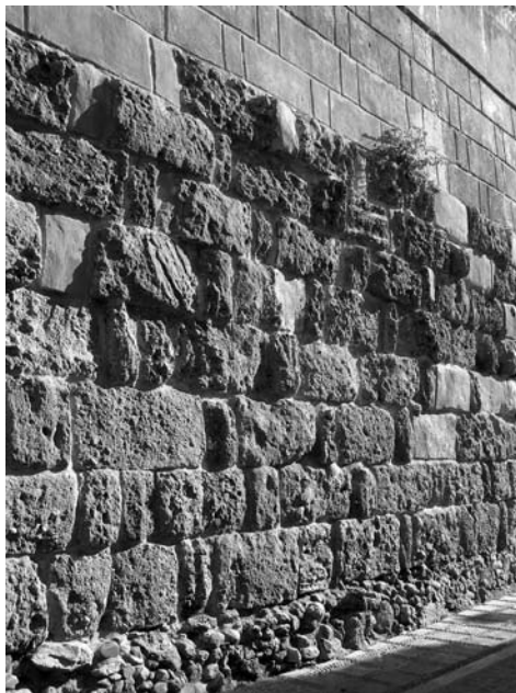
LÁMINA 4. Fábricas de sillería del lienzo sur del castillo o alcazaba de Marbella (Málaga).
