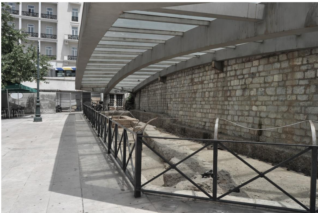
Fig. 10: Sistema de protección de la canalización clásica en Plaza Sintagma. (Elaboración propia).
