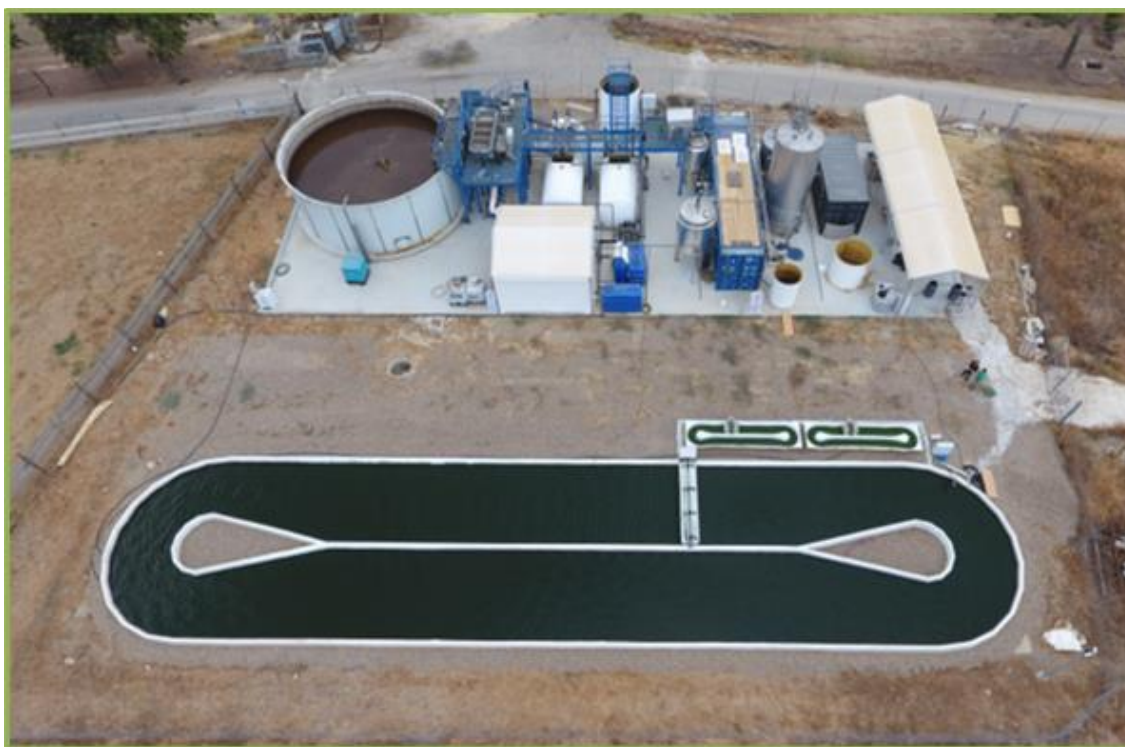
Figura 2. Sistema Water2Return instalado en Matadero del Sur, Salteras (Sevilla)
