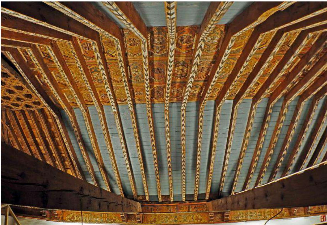
Imagen 1. Vista de la techumbre desde uno de sus laterales. Se aprecian varios pares y nudillos, el almizate, dos tirantes y parte del arrocabe en el lado de la Epístola.
