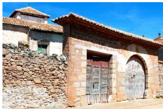
Fig. 24. Detalle de la entrada.
