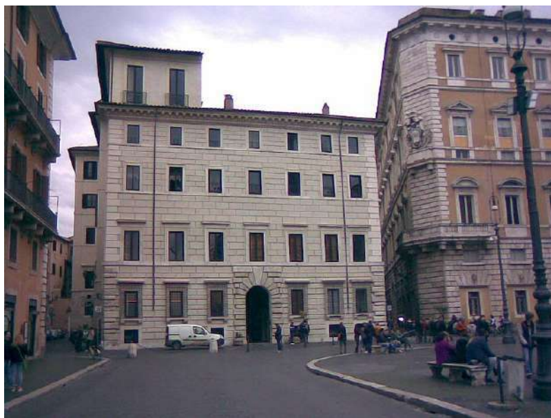
Ilustración 10: Fachada del Palacio de los Torres en la Plaza Navona (Fuente de la imagen: https://it.wikipedia.org/wiki/Palazzo_De_Torres_-_Lancellotti ).
