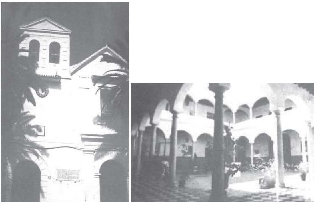
Ilustración 6 (izquierda): fachada de la iglesia del Convento de los Ángeles.
