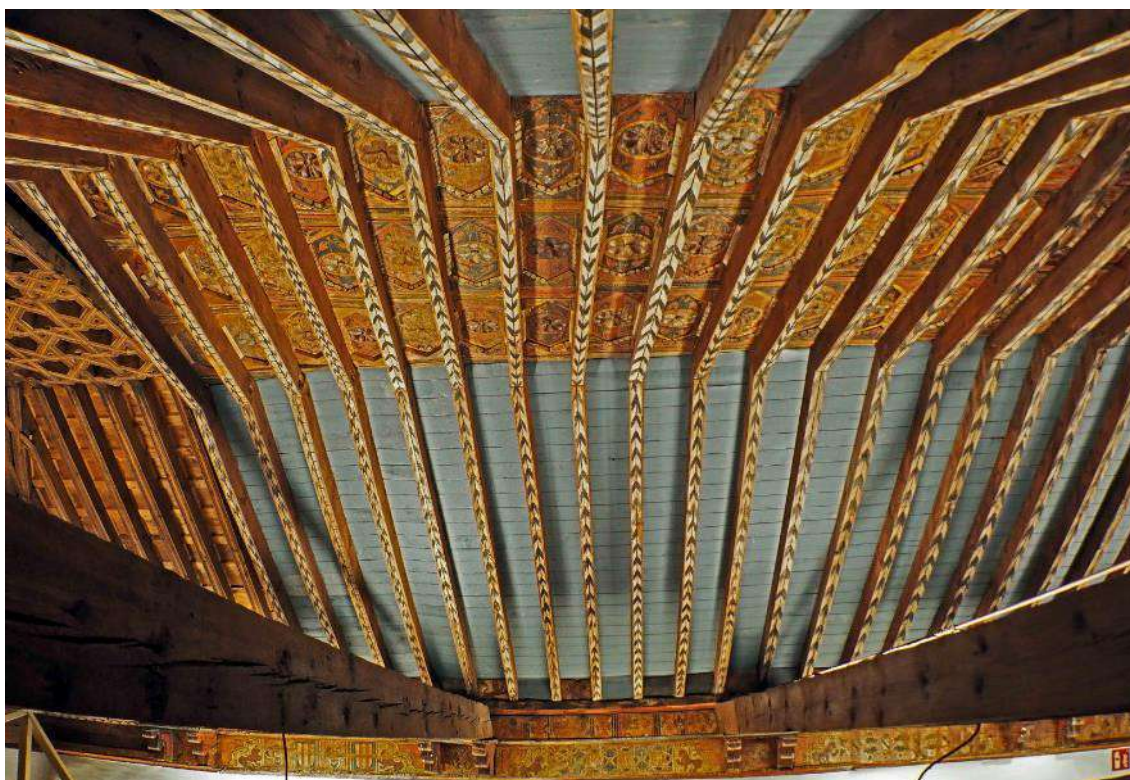
Imagen 1. Vista de la techumbre desde uno de sus laterales. Se aprecian varios pares y nudillos, el almizate, dos tirantes y parte del arrocabe en el lado de la Epístola.
