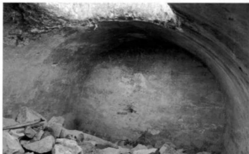
24. *Interior del aljibe, pequeña habitación de planta rectangular y cubierta abovedada en cuyo centro se aprecia el orificio practicado para la toma de agua*
