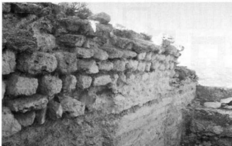
29. Aljibe del recinto fortificado Jardín del Moro. Se aprecia en la fotografía el reboque interno de mortero y el arranque de la bóveda de medio cañón que le servía de cubierta, hoy desaparecida, que cuenta con la notable originalidad de estar edificada en piedra (Foto: J.L. del Pino)
