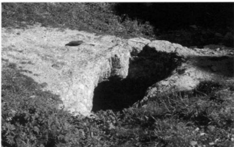
4. En las fotografías anteriores hemos visto un ejemplo de aljibe completamente subterráneo (Iznájar) y otro de aljibe semiexcavado (Medellín). En esta vista exterior del aljibe de Castro el Viejo se aprecia la tercera modalidad descrita: depósito excavado del que sólo sobresalen en superficie los elementos de cubierta, situándose el arranque de la bóveda a ras de suelo
