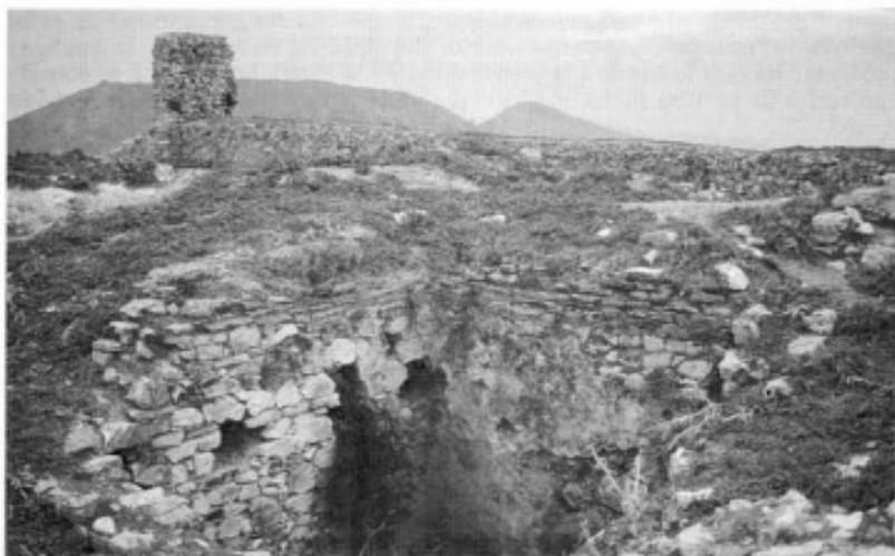
32. Aljibe del castillo de Santa Eufemia, en cuyas paredes se puede apreciar la alternancia del ladrillo en una construcción en la que predomina de forma notable la piedra
