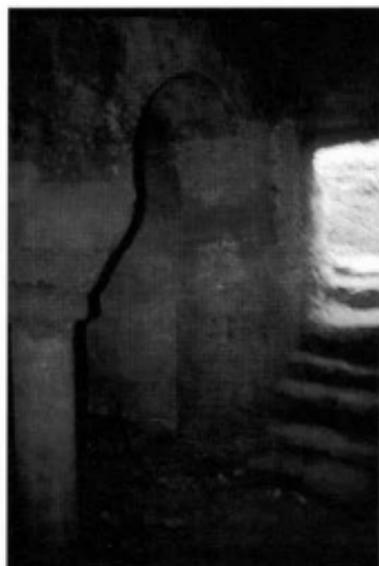
7. En esta vista interior del aljibe del castillo de Medellín se aprecian con nitidez los restos de pintura rojiza que cubren sus paredes hasta el arranque de las bóvedas (dos de medio cañón separadas por arcos de herradura apoyados sobre una pilastra central)
