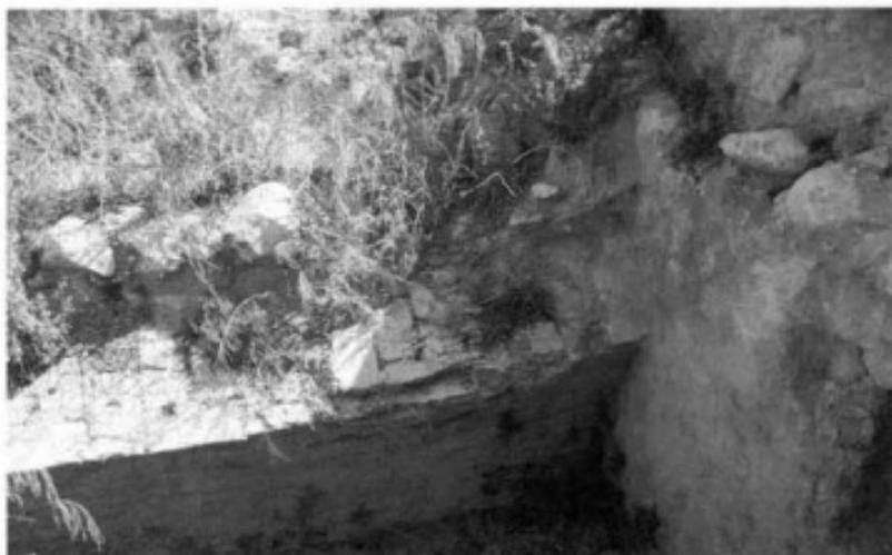
34. Detalle del aljibe del castillo de Zaheros, en donde se aprecia la pared edificada en ladrillo con el inicio de la curva provocada por la bóveda de medio cañón desaparecida que lo cubría
