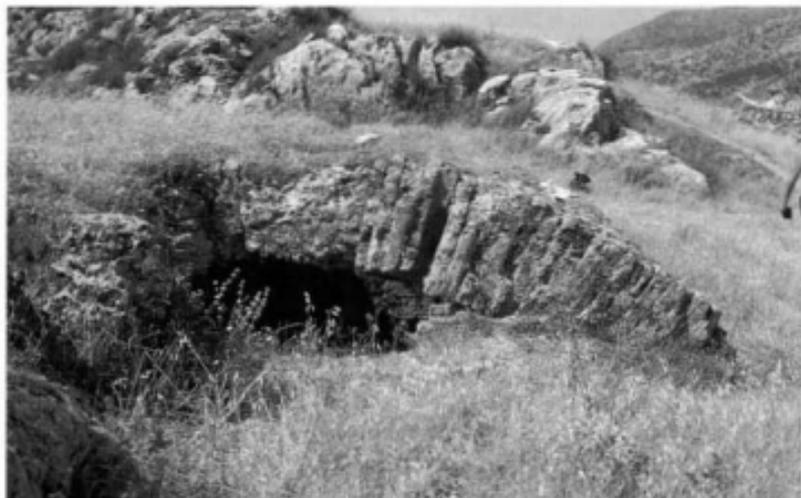
20. Vista frontal de la bóveda de medio cañón de lastrillo, de grandes dimensiones, que cierra el depósito de Carcabuey y cuyo arranque se sitúa al nivel del terreno
