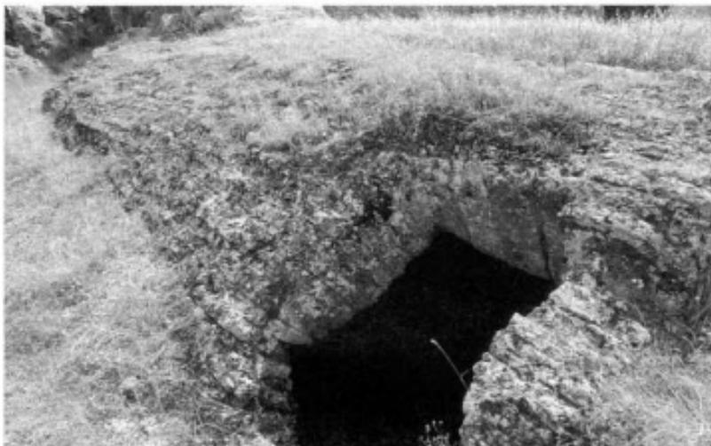
22. Orificio para la toma de agua practicado en un lateral de la bóveda que cubre el depósito del castillo de Carcabuy
