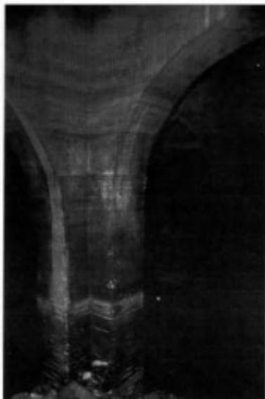
15. *Machón central cruciforme del aljibe de Izdijar con el arranque de los cuatro arcos transversales que delimitan los espacios interiores cubiertos mediante bóvedas de crucería*
