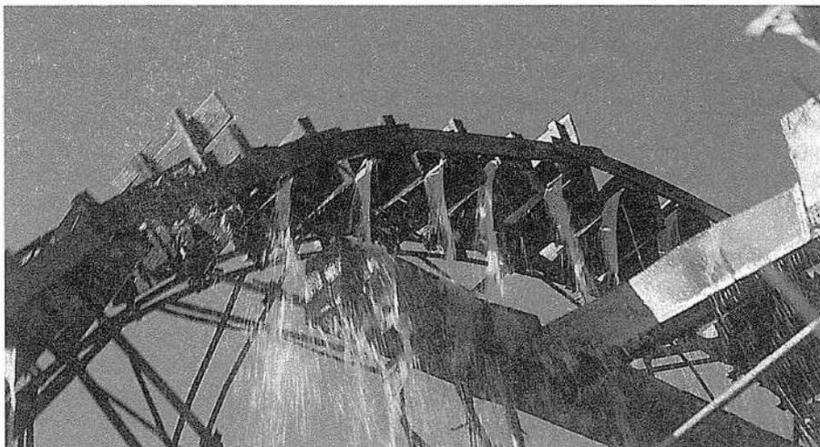
*Figura 6:* En esta vista de la noria de Jauja en funcionamiento se puede apreciar cómo se produce el vertido del agua de los cangilones, por el costado interno de la noria, sobre el ñaquil. A éste va unida la mangueta o artesilla que sirve de conexión con el acueducto que transporta el agua extraída.
