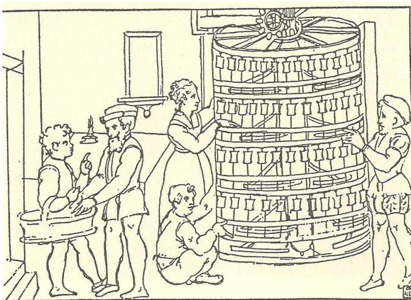
**Fig. 2.** Torno circular de seda accionado por energía hidráulica según un manuscrito ilustrado de 1500 (Museo de Budapest). (Imagen propia del autor).
