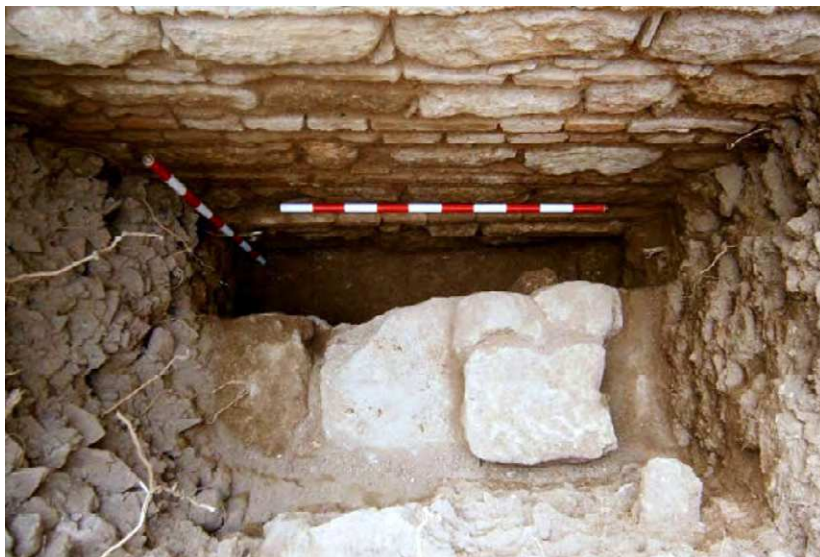
Fig. 5. Sondeo 3 de 2014 muro que separa la crujía norte del patio que adquiere un desarrollo inusual en la cimentación. Se advierte un sobredimensionado de la cimentación con una técnica mixta de sillarejo y ladrillo que parece indicar la presencia de unos potentes rellenos. (Imagen propia de los autores).
