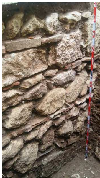
Fig. 4. Forro tardoantiguo sobre muralla romana a -3,80 bajo rasante actual. (Imagen propia de los autores).
