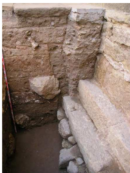
Figs. 18 y 19. Detalle de las banquetas de cimentación del muro de fachada principal de la iglesia.
