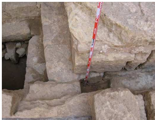
Fig. 14. Portada. Detalle de las banquetas de cimentación.
