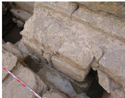
Fig. 15. Portada. Alzado oeste de la cimentación.
