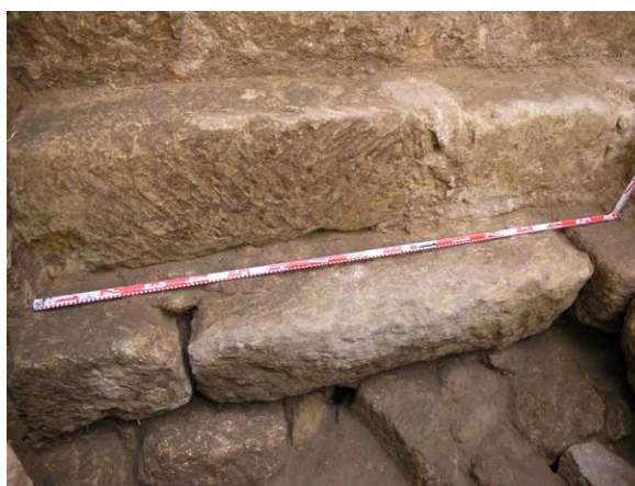
Figs. 18 y 19. Detalle de las banquetas de cimentación del muro de fachada principal de la iglesia.
