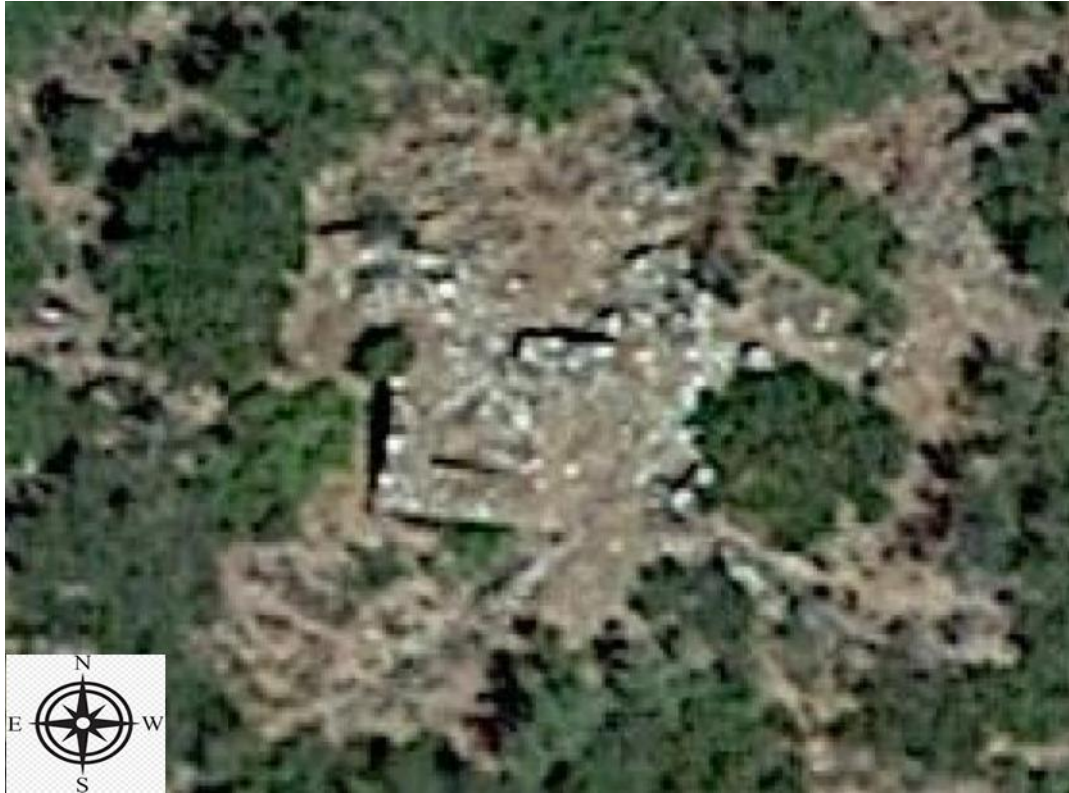
Fig. 17. Imagen aérea de la torre de Casa fuerte. (Google Earth).
