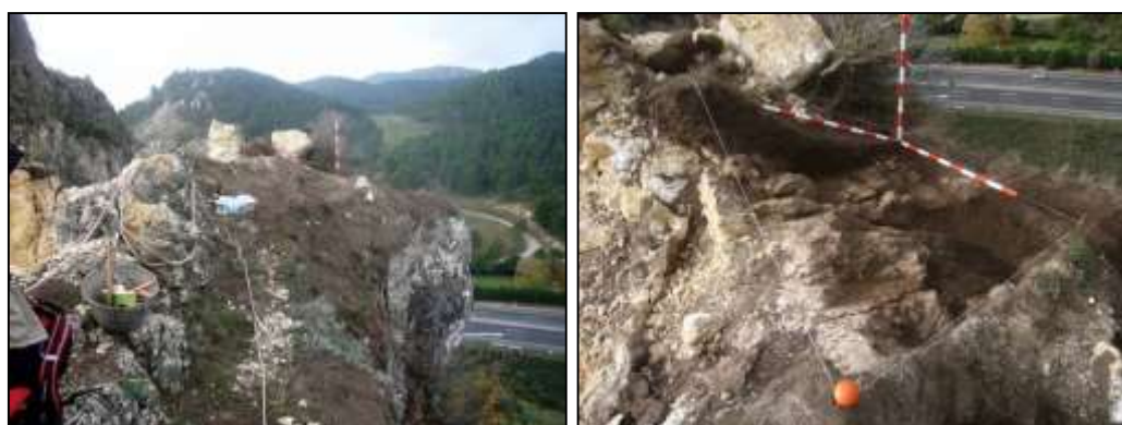
Fig. 2. Proceso y finalización de la excavación en el sector del puesto de vigilancia.
