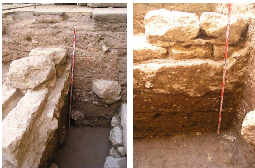
Fig. 26. Canalización, cimentación de la pared este.
