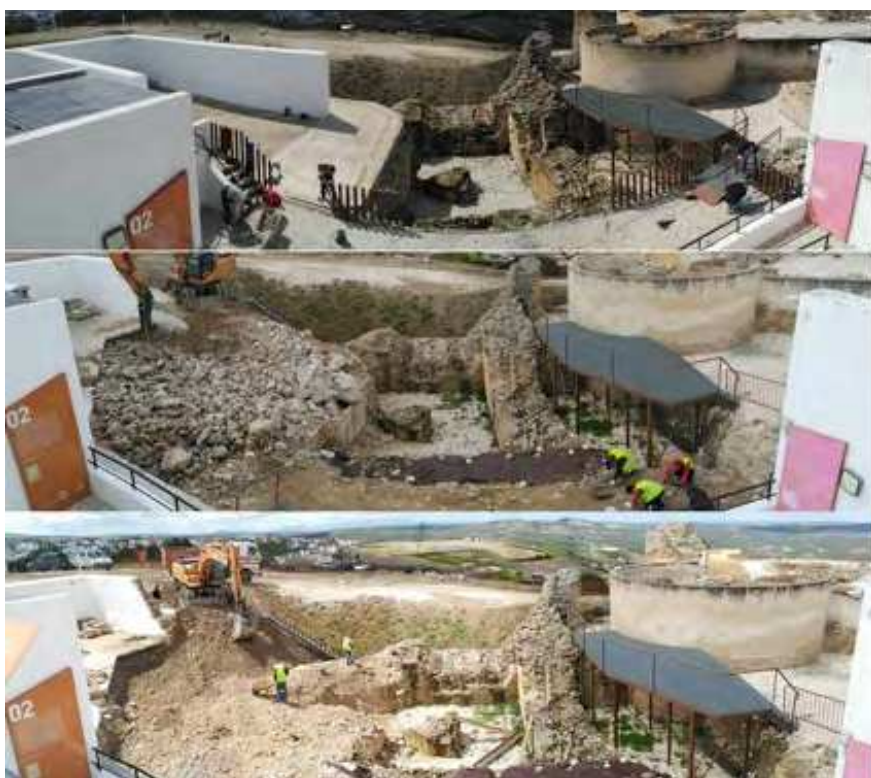
Fig. 5. Secuencia del proceso de retirada de la losa de cimentación y descubrimiento de la torre. Fotografía: elaboración propia.
