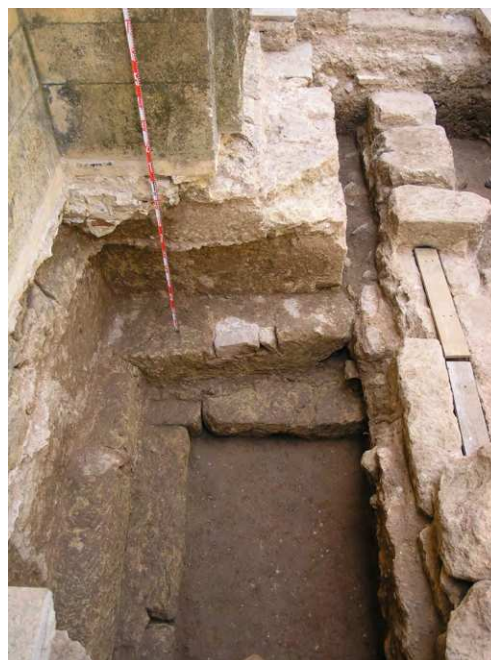
Fig. 10. Cimentación de la portada de la iglesia desde el norte.
