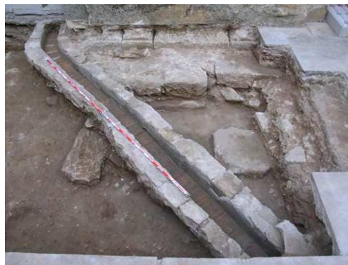
Fig. 6. Paredes y fondo de la canalización anterior.
