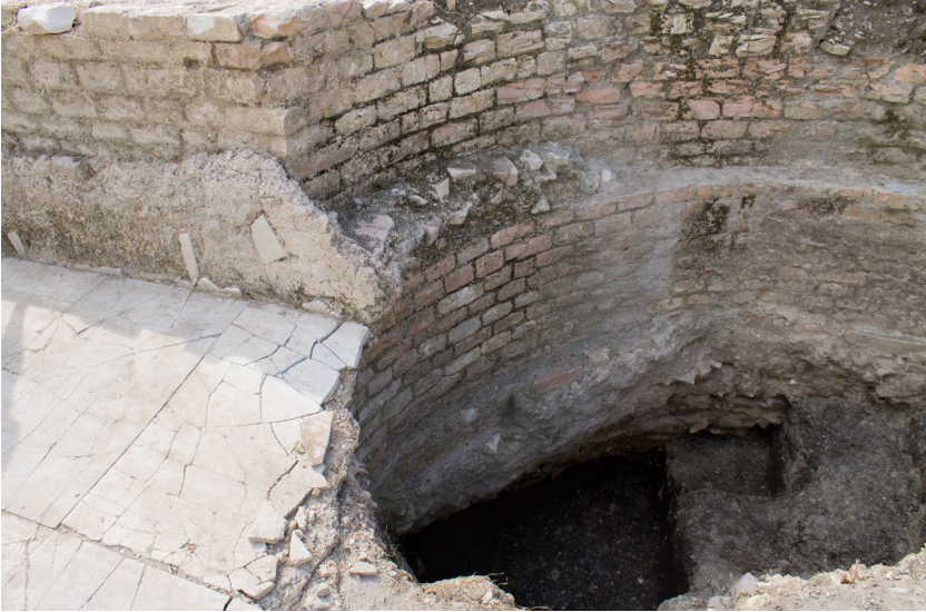
Fig. 23 - Particolare delle fondazioni dell'Augusteo visibile nell'abside. Si vedono perfettamente lo spiccato del muro, il piano di appoggio del pavimento e i due nuclei di fondamenta, il superiore realizzato in opera vittata e l'inferiore realizzato contro terra (foto M. Gasparini).
