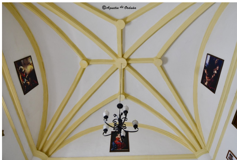
Fig. 8. Bóveda de la sacristía.
