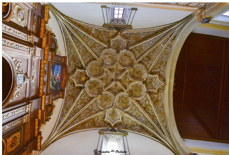
Fig.4. Bóveda estrellada de la Capilla Mayor.
