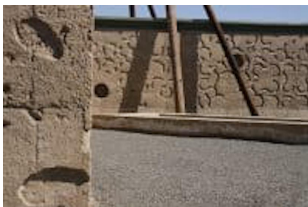
Fig.5. Tapial reusado en Paralelo. Fuente: Fotografía de Javier Zayeck, TAC.
