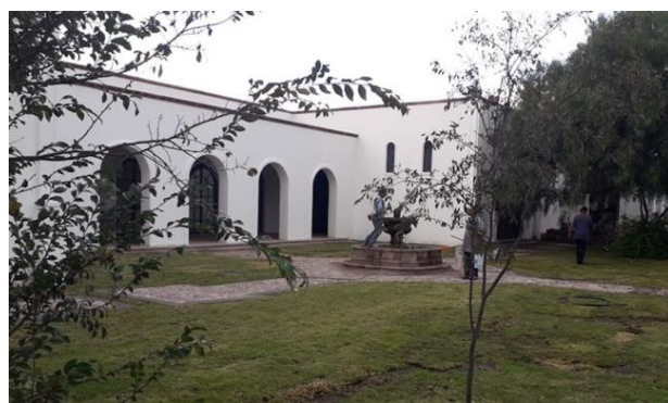
Fig.3. Construcción tipo hacienda con caballerizas adaptadas en Vinícola Dos Búhos. Fuente: Fotografía de Vinícola Dos Búhos.
