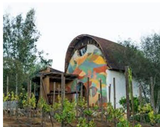
Fig.4. Construcción estilo cob en Solybarro Fuente: Fotografía de Aimé Desponds.
