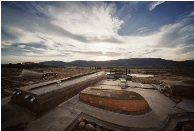
Fig. 9. Casco de barcos y elementos marinos como bóveda de cañón en Vinícola Vena Cava Fuente: Fotografía de Javier Zayeck, TAC.
