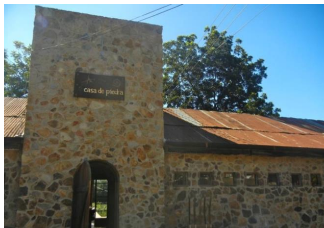
Fig.1. Construcción con piedras seleccionadas de la región en Vinícola Casa de Piedra. Fuente: Fotografía de Javier Zayeck, TAC.
