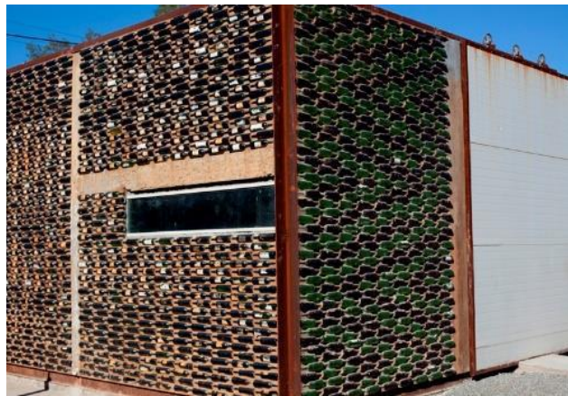
Fig.6. Madera y botellas de vidrio recicladas en la Estación de Oficios. Fuente: Fotografía de Javier Zayeck, TAC.
