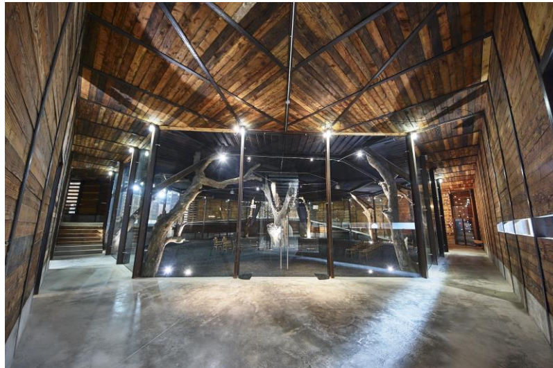
Fig. 13. Madera reciclada y estructura de acero en Vinícola Bruma y hotel boutique Casa 8. Fuente: Fotografía de Javier Zayeck, TAC.
