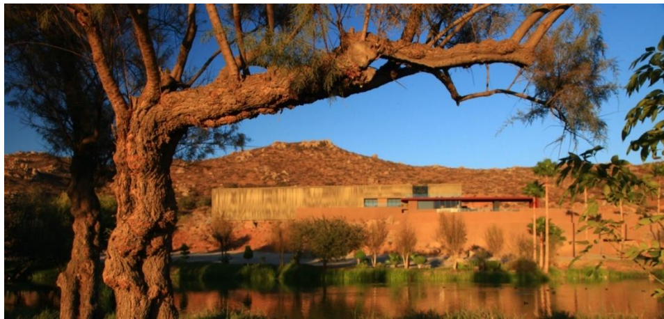
Fig. 11. Integración con el entorno en Monte Xanic Fuente: Fotografía de Sófoles Hernández, Garduño Arquitectos.
