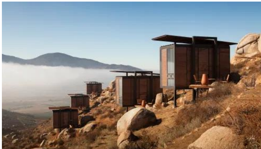
Fig.8. Estructura de acero y madera para elevar la habitación en Encuentro Guadalupe. Fuente: Fotografía de Luis García, Edgar Lima, Arquine.
