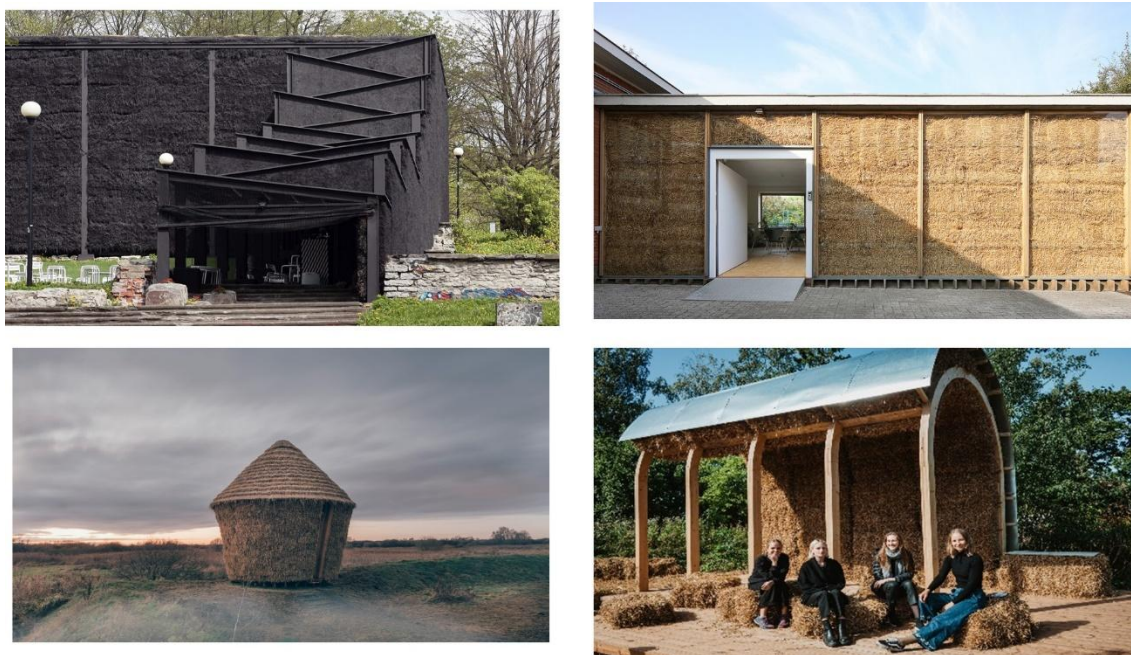
Fig. 1. De izquierda a derecha y de arriba abajo: Teatro de Paja NO99 (Tallin, Estonia). Salto Architects. 2011. (Fuente: Martin Siplane) https://www.archdaily.com/150293/no99-straw-theatre-salto-ab/5014de8b28ba0d5828000a18-no99-straw-theatre-salto-ab-photo?next_project=no (19 septiembre 2024); Refuge II (Nevele, Bélgica). Wim Goes Architectuur. 2014. (Fuente: Filip Dujardin). https://www.archdaily.com/800577/refuge-ii-wim-goes-architectuur/583f4589e58ece9-e19000023-refuge-ii-wim-goes-architectuur-photo (19 septiembre 2024); Mother Pavilion (Wicken, Reino Unido). Studio Morison. 2020. (Fuente: Charles Emerson). https://www.archdaily.com/934962/mother-pavilion-studiomorison/5e6002826ee67e6c2b000269-mother-pavilion-studio-morison-photo (19 septiembre 2024) y Capilla de Paja (Tallin, Estonia). Estudio Kollektiiv. 2022. (Fuente: Jelena Rudi). https://www.artun.ee/en/eka-students-pollinator-highway-installations-now-open/ (19 septiembre 2024).
