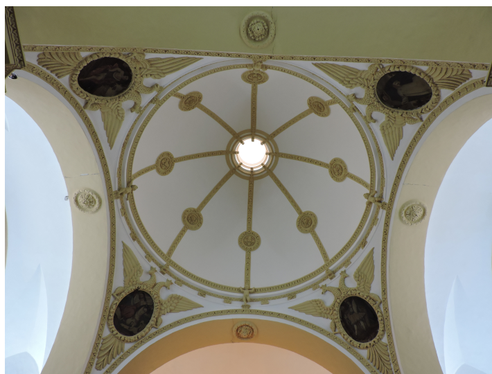
Fig. 14. Crucero. Cúpula. Vista general. Iglesia. Albánchez (Almería).
