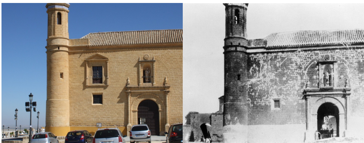
Fig. 8. Fotografía de comienzos de siglo . Puede apreciarse la fachada de las Escuelas Menores (a la izquierda) y la ventana añadida, así como la campana en el torreón.
