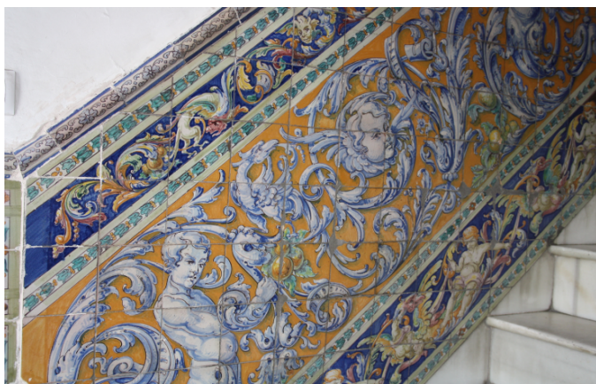
Fig. 9. Revestimiento de escalera en edificio de Paseo de Colón nº 12 de Sevilla.
