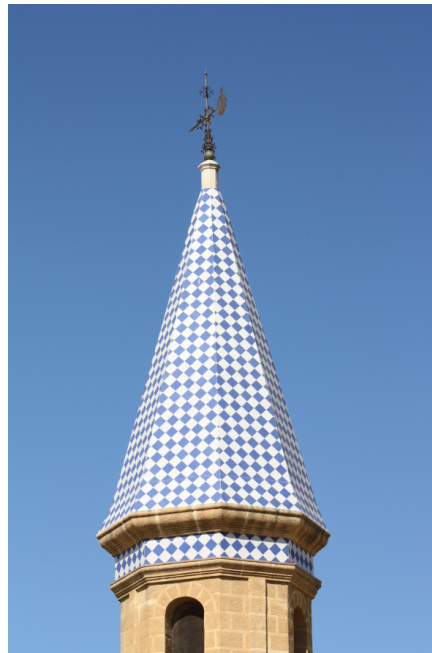
Fig. 10. Chapitel del torreón revestido de azulejo vidriado.
